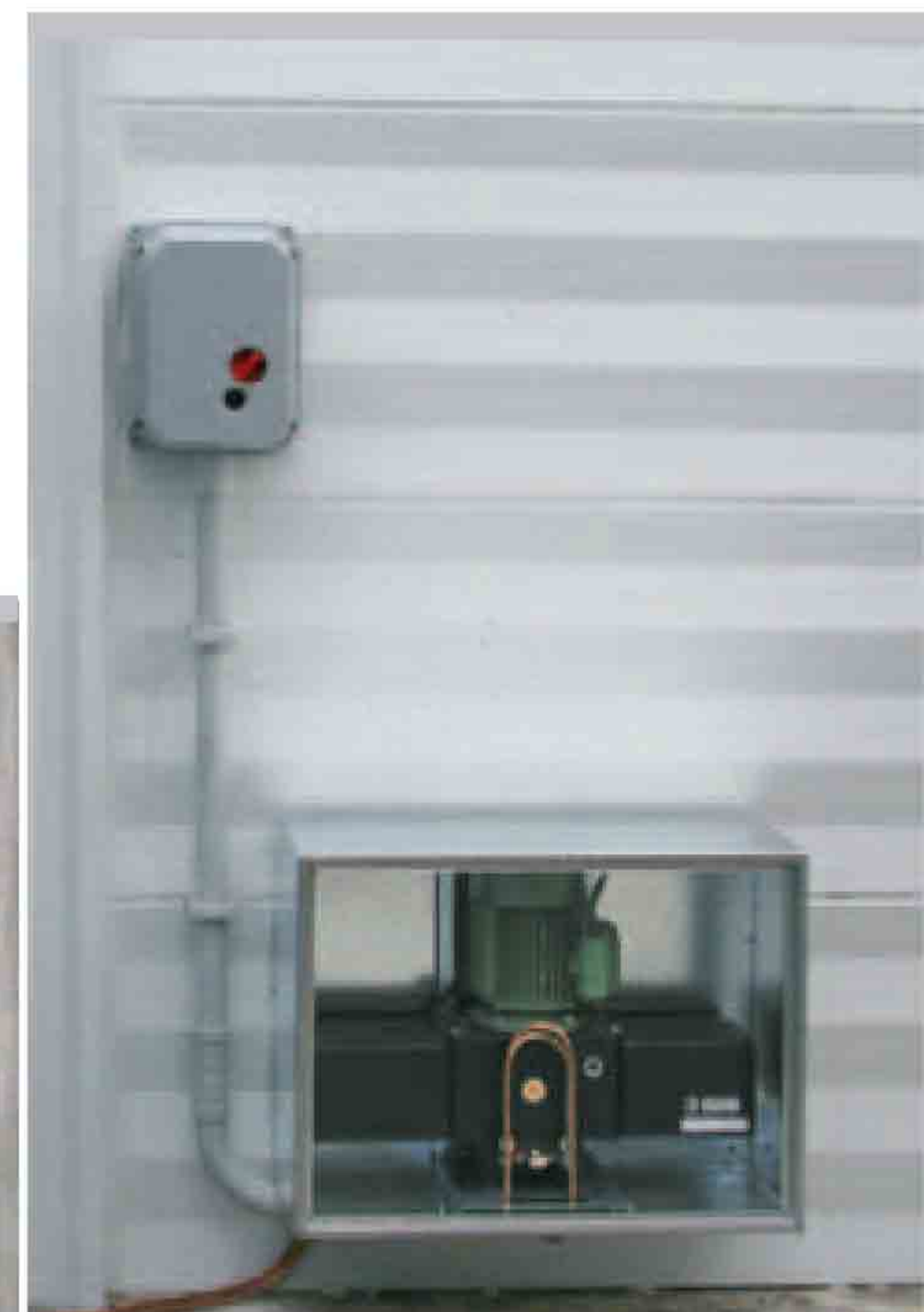
Instalación de la Centralita hidráulica
